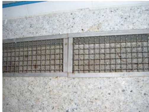
ภาพที่ 28 ทางระบายน้ำแบบเปิด
