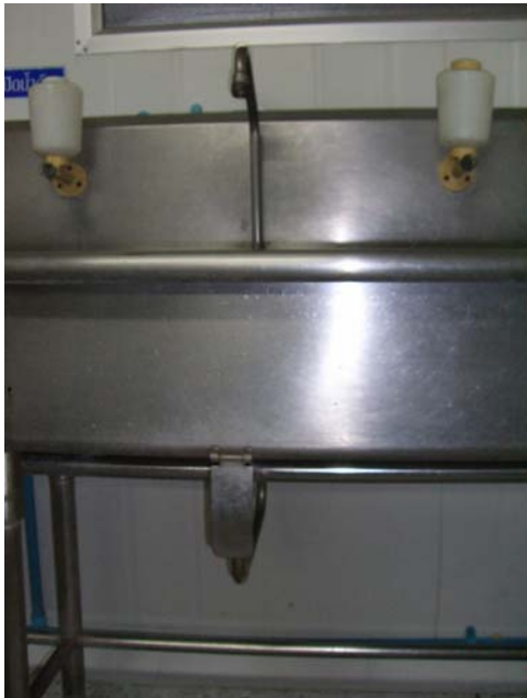
ภาพที่ 11 อ่างล้างมือชนิดที่ไม่ใช้มือหรือแขนปิด-เปิด
