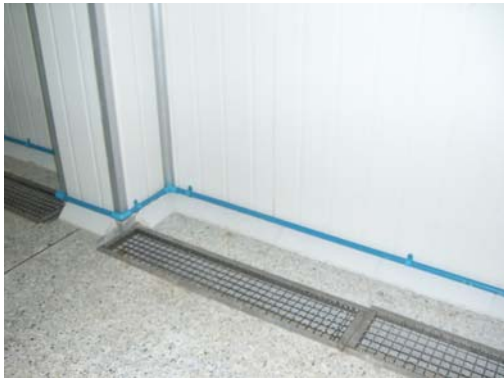
ภาพที่ 28 ทางระบายน้ำแบบเปิด
